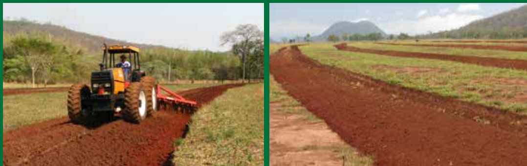
Figura 39: Construção de Terraço, visando conservação de solo.
